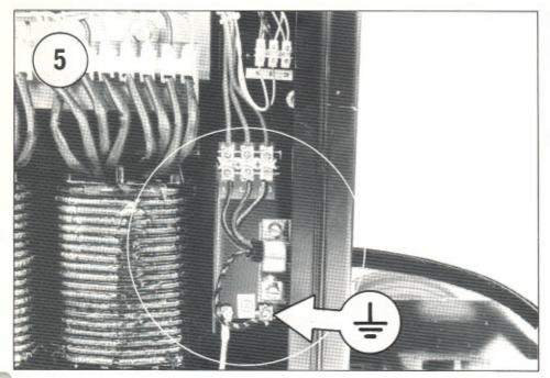
VERKKOKAAPELIN KYTKENTÄ KOPPLING AV ANSLUTNINGSKABEL CONNECTION OF MAINS CABLE ANSCHLUSS DES NETZKABELS
